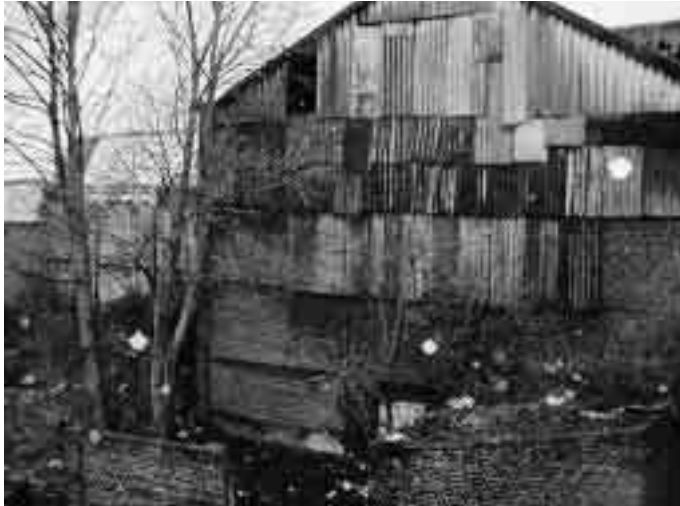
Figure 2 – Vue arrière d'un site partiellement rénové
